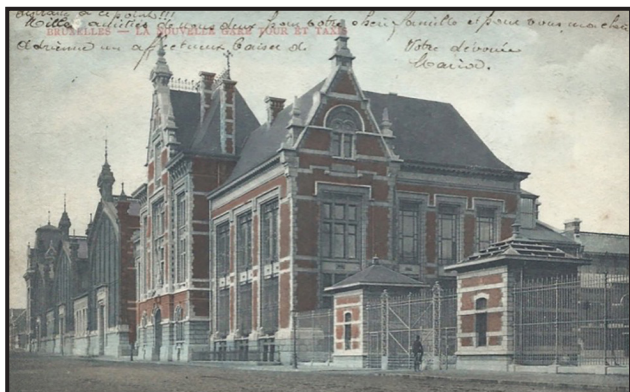
Het station 'Bruxelles-Tour et Taxis'.
