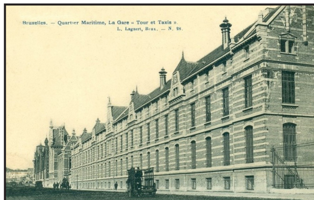
Het goederenoverslagstation van 'Tour et Taxis'.
