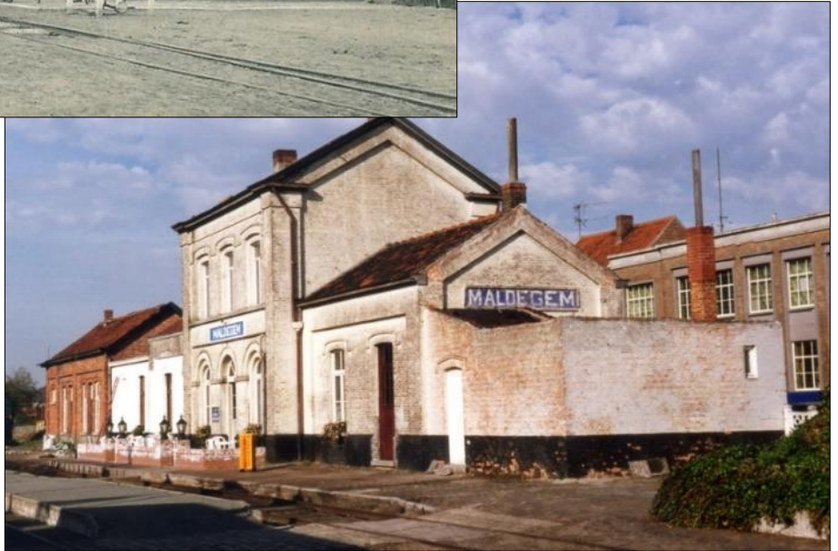
Het voormalige station en telegraafgebouw. Dit doet vandaag dienst als het Stoomcentrum Maldegem.
